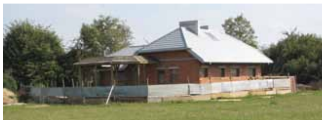
• Centrum Kultury w Mokrosęku w trakcie budowy.
