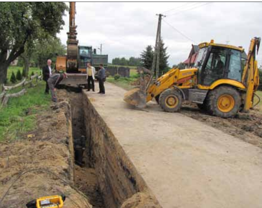
• Budowa kanalizacji w Piasecznie.
